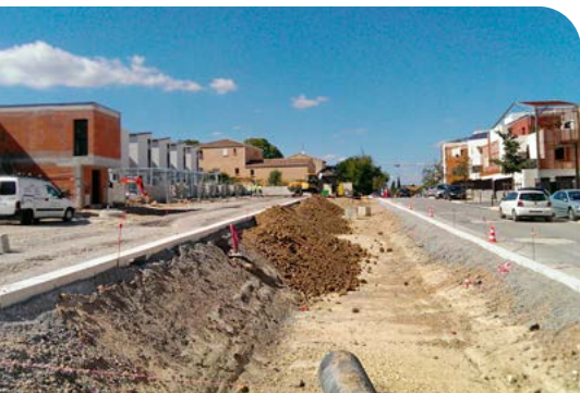
Noues d'infiltration, en chantier, Roque Fraïsse Écoquartier, Montpellier, France, 2016. (Les Ateliers UP+, Christian Matteau Architecte Paysagiste, Montpellier).
