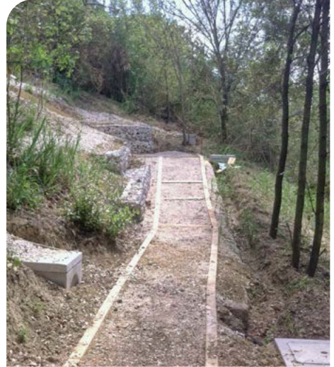
Système de tranchées d'infiltration, chemin de randonnée urbain, Monte Mario, Rome, Italie, 2016. (Simone Amantia Scuderi, Rome, Italie – photo Simone Amantia Scuderi).
