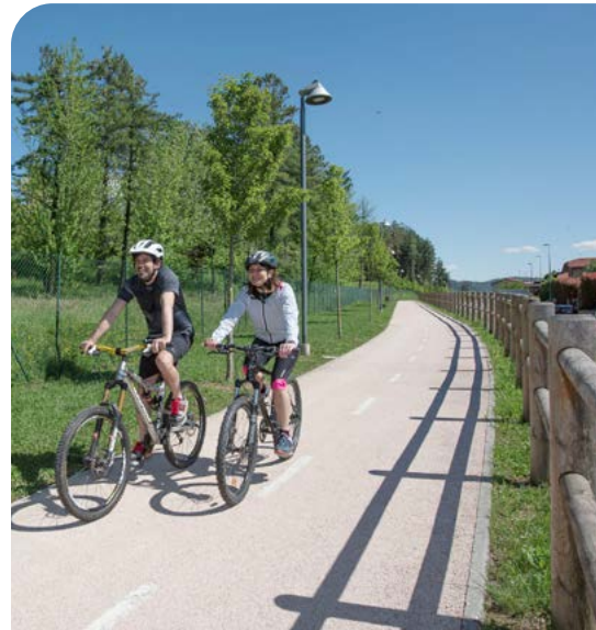
Piste cyclable avec revêtement perméable, Calusco, Bergame, Italie. (i.idro DRAIN, Italcementi S.p.A. – photo Italcementi).
