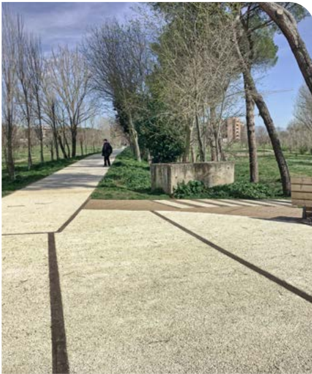
Revêtement drainant, Parco Talenti, Rome, Italie, 2018. (Tullio/Polci/Dallari, Rome – photo Maria Cristina Tullio).
