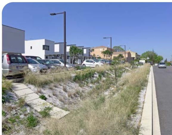
Noues d'infiltration, Roque Fraïsse Écoquartier, Montpellier, France, 2016. (Les Ateliers UP+, Christian Matteau Architecte Paysagiste, Montpellier).
