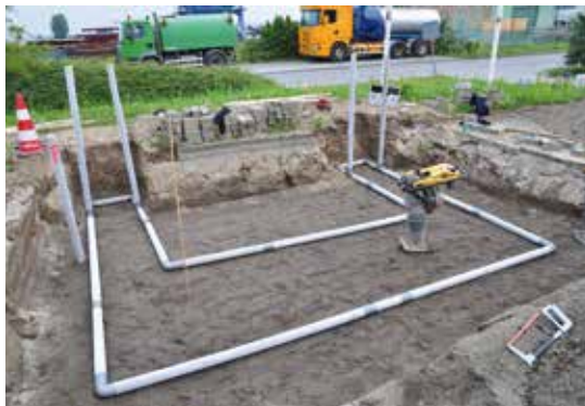
Excavation réalisée et système d'aération en place.
