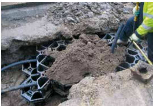
La matrice de caissons est remplie de terre. Noter la présence dans la matrice des tubes servant à l'aération et l'irrigation.
