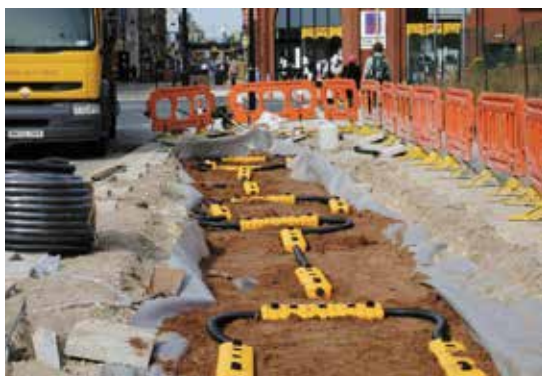
Installation du système d'irrigation et d'aération sur la tranchée remplie de terre végétale.
