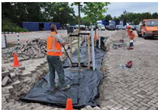
Une fois les arbres plantés, mise en place d'un géotextile au-dessus du substrat d'enracinement avant la réalisation des couches de fondation du revêtement de surface.
