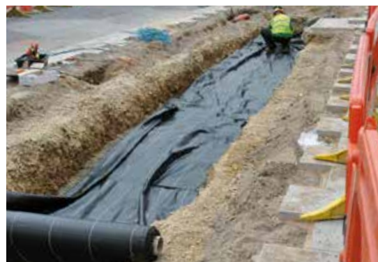
Pose d'un géotextile à vocation de barrière anti-racines.
