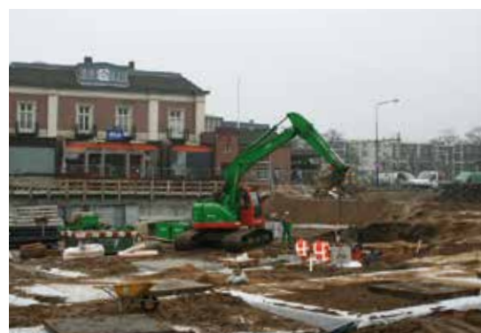
Des couvercles sont placés temporairement pour protéger les trous destinés à accueillir les arbres.
