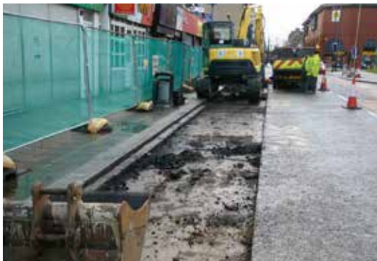
Les travaux d'excavation commencent sur Ocean Road (voir étude de cas n°2 p. 30).
