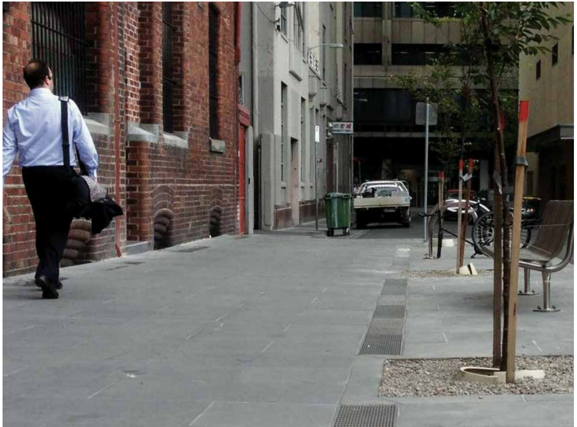
Une tranchée d'infiltration guide les eaux de ruissellement de ce trottoir de Melbourne vers le mélange terre-pierre dans lequel poussent les arbres. Image : Ville de Melbourne
