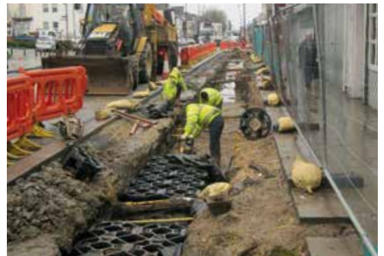
Compaction du fond de la tranchée et positionnement des caissons.
