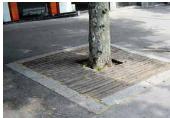
Le platelage en bois est facilement adaptable à un arbre existant. Image : Frédéric Ségur
