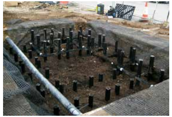
Remplissage des caissons avec de la terre végétale.
