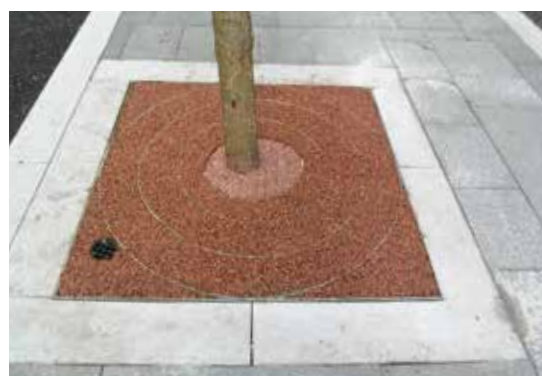
Grille à éléments concentriques amovibles sur le boulevard de Swansea (voir l'étude de cas n°17 p. 78). Noter la bouche noire pour l'aération et l'irrigation. Image : Sue James
